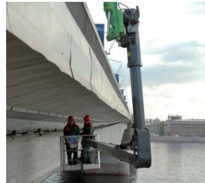
Das System Space ermöglicht auch das Arbeiten auf Höhen, die mehr als 9 Meter unter dem Straßenniveau liegen.
