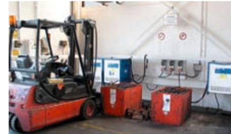
Bild 3-6: Ladestation für Flurförderzeuge und deren Wechselbatterien in einer Werkhalle mit natürlicher Lüftung
