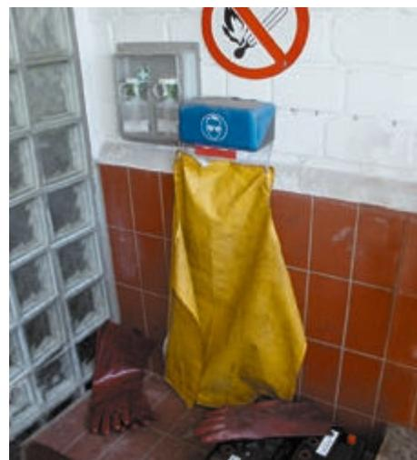
Bild 7-6: Bereitgestellte PSA in einer Batterieladestation
