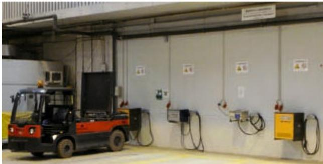
Bild 6-1: Sicherheitskennzeichnungen an den Ladepunkten innerhalb einer Ladestation
