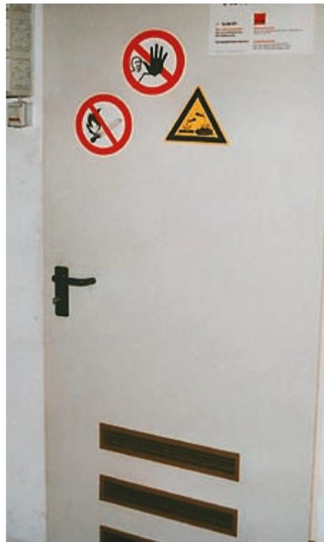
Bild 3-4: Lüftungsgitter zur natürlichen Lüftung in der Zugangstür einer kleinen Ladestation für Pkw-Starterbatterien.
