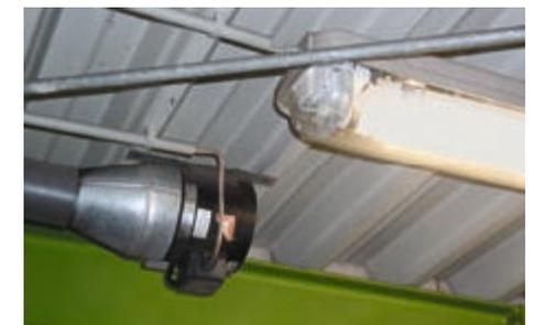
Bild 3-7: Technische Lüftung mit Sauglüfter und Deckenleuchte in Ex-Schutz
