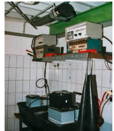
Bild 3-3: Ladestation für Batterien, abgestellt in säurefesten und ableitfähigen Kunststoffwannen. Die Ladegeräte stehen auf einer nicht brennbaren Konsole.
