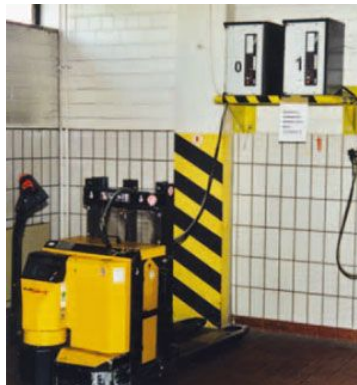
Abbildung 6: Batterieladestationen
